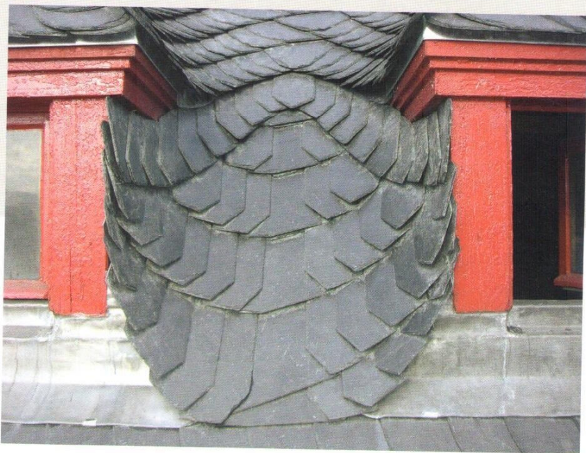
Filigranarbeit mit Kehlsteinen mit geradem Bruch.
