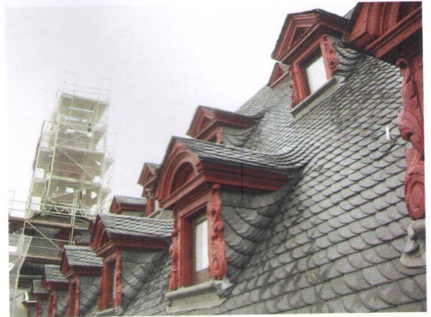
Dachlandschaft über dem Jesuitenplatz mit Sattel- und Spitzgauben sowie eingerüstetem Turm.
